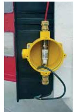
Ein Druckschalter kann verwendet werden, um ein Alarmsignal auszulösen
