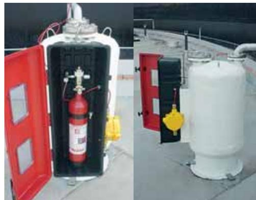
Im Falle eines Feuers birst der FireDETEC®-Sensorschlauch und löst das System aus – was Schaum-Löschmittel durch die Löschdüsen um den Umfang herum freigibt.
