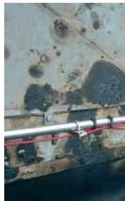
Das Sensorschlauch- und Schaumlöschsystem ist um das Tankdach herum direkt über der Dachabdichtung installiert
